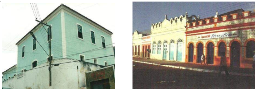
Arquitetura Colonial do século XIX (Casa de Câmara e Cadeia) e Prédios Históricos no centro da Cidade
