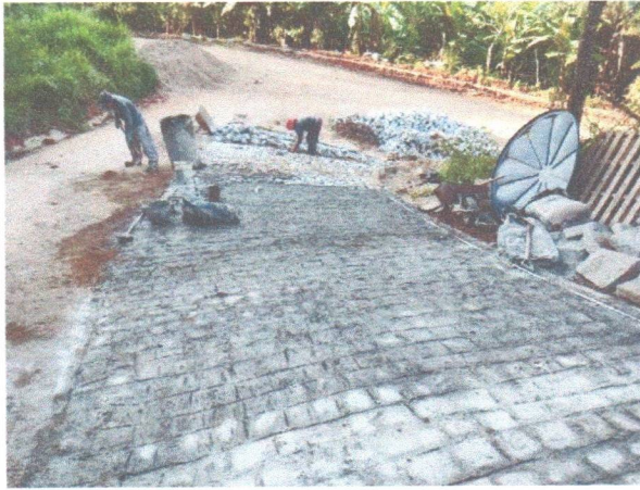
FOTO 1: LADEIRA ZE BUCHUDO - TRECHO EM ANDAMENTO;
