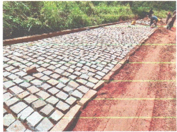
FOTO 4: MEIO-FIO GRANÍTICO NO EIXO DA 2ª LADEIRA;
