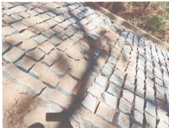
FOTO 3: TRECHO CONCLUÍDO - LADEIRA ZÉ BUCHUDO - RE CRAVA A CADA 30M;
