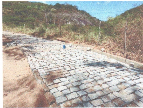
FOTO 4: TRECHO CONCLUÍDO - LADEIRA ZÉ BUCHUDO MEIO-FIO DE RE CRAVA NO EIXO;
