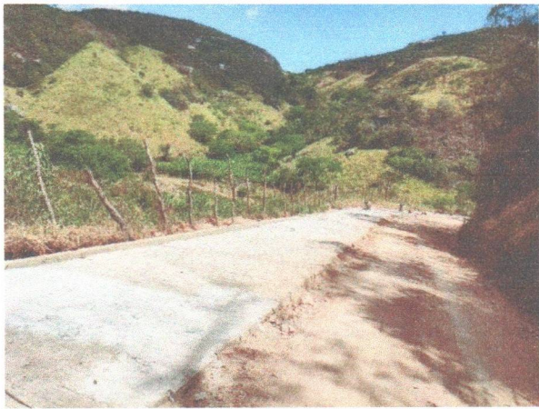
FOTO 1: TRECHO CONCLUÍDO - LADEIRA ZÉ BUCHUDO;
