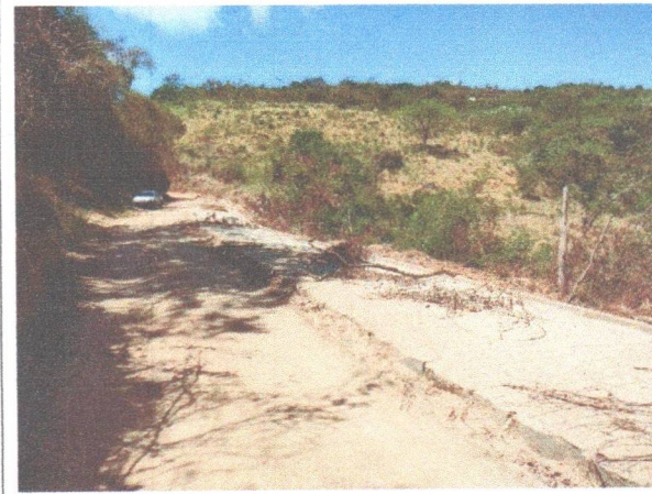
FOTO 6: TRECHO CONCLUÍDO - LADEIRA ZÉ BUCHUDO.
