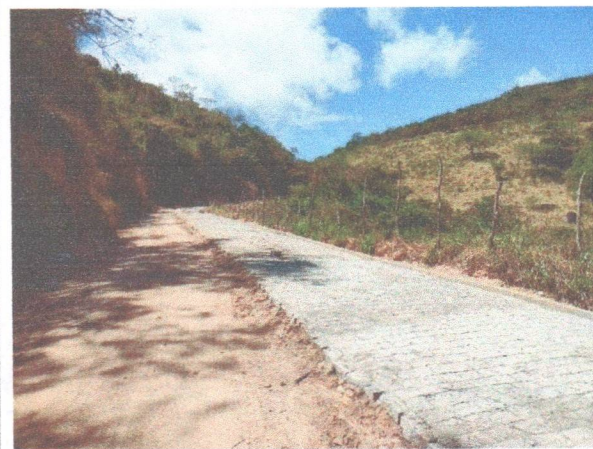
FOTO 5: TRECHO CONCLUÍDO - LADEIRA ZÉ BUCHUDO;
