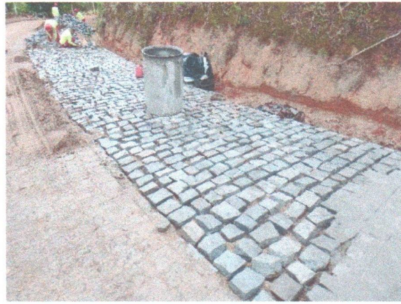
FOTO 2: LADEIRA ZÉ BUCHUDO-EXECUÇÃO;
