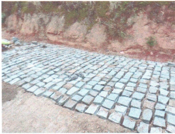
FOTO 1: LADEIRA ZÉ BUCHUDO-EXECUÇÃO;
