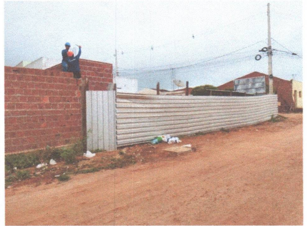
FOTO 2: Tapume em telha metálica;
