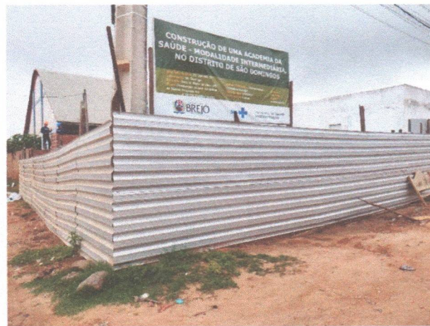
FOTO 3: Tapume em telha metálica;
