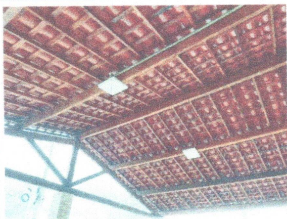
FOTO 7: Pintura em Verniz na trama da cobertura;
