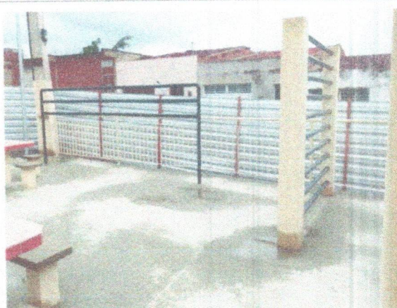
FOTO 8: Pintura do equipamento e Guarda-Corpo;
