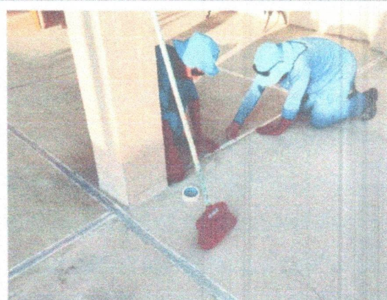
FOTO 4: Execução de selante nas Juntas
