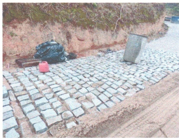
FOTO 2: LADEIRA ZÉ BUCHUDO-EXECUÇÃO;
