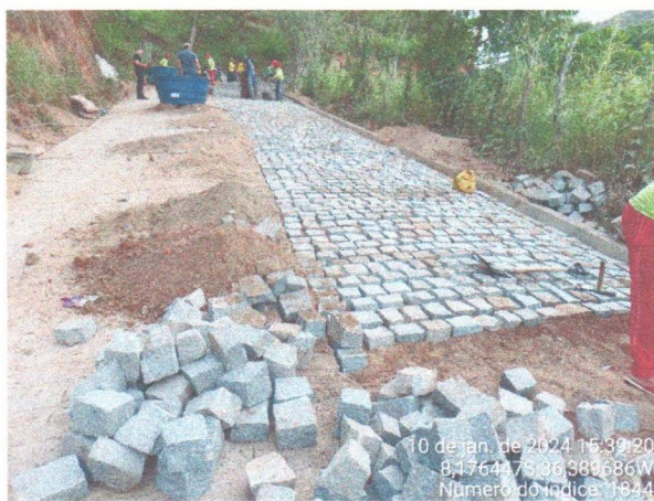
FOTO 1: LADEIRA ZÉ BUCHUDO-EXECUÇÃO;
